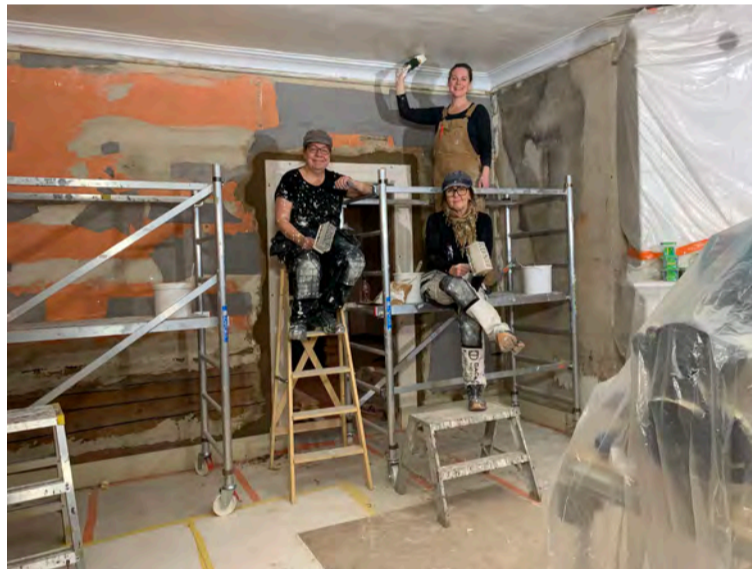
Samarbete med Älfgärdet Restaurering & Byggnadsvård (Forshaga) och Hantverket Måleri & Byggnadsvård i Arvika AB. Limfärgsmålning av ett pappspänt tak i ett 1700-tals hus strax före jul.
